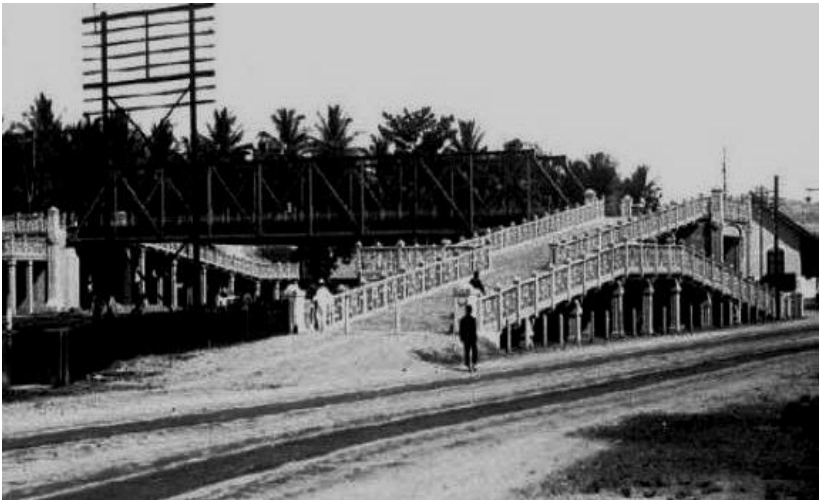
Gambar 14. Footbridge , 1925 Sumber: kitlv.nl
