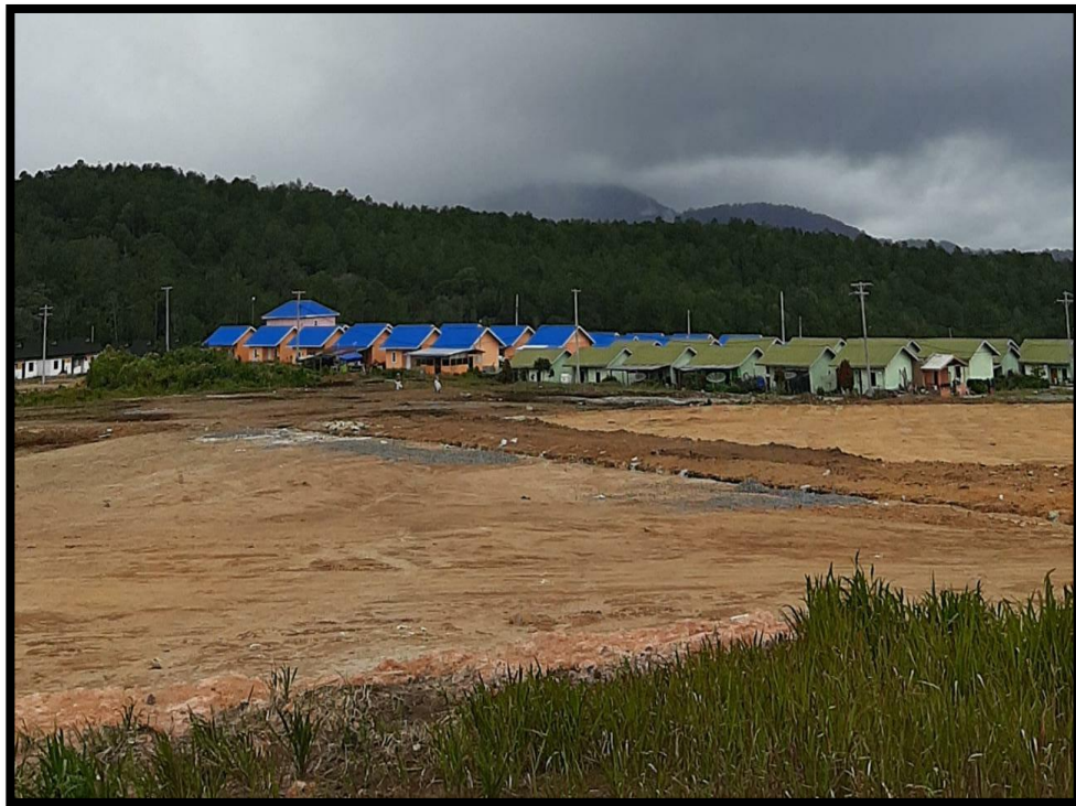
Gambar 4. Proses Pembangunan Pemukiman Penduduk Kawasan Relokasi Siosar Untuk Tahap 4
