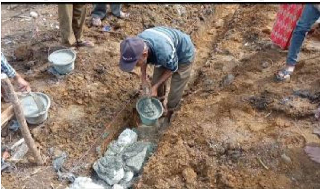
Gambar 6 : Menuang semen pada batu yang telah diletakkan agar pondasi kuat
