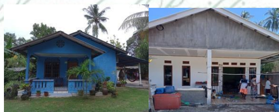
Gambar 1. Bentuk Bangunan dan Lingkungan Rumah
