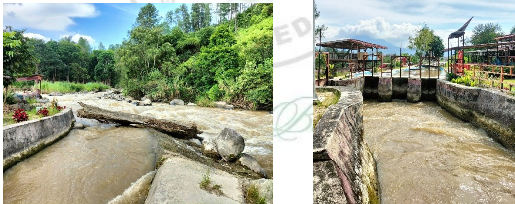
Gambar 5.1 Kondisi Bangunan Utama Sumber : Dokumentasi Peneliti (8 Februari 2024)
