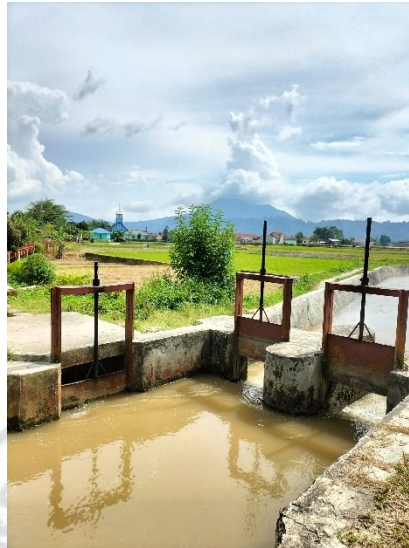
Gambar 5.3 Kondisi Komponen Bangunan Bagi dan Sadap
