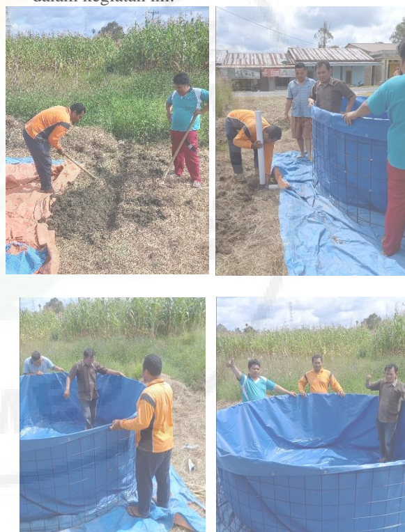
Gambar 1. Pemasangan Kolam Terpal.
