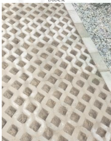
Gambar 8. Pengikatan Material Grass Block Dengan Material Pasir Dan Tanah.
