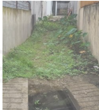
Gambar 5. Kondisi Awal Jalan Yang Dibersihkan.
