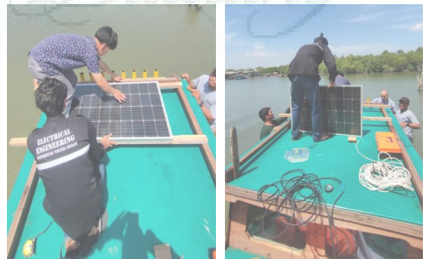
Gambar 4.b. Pemasangan Modul Solar Cell
