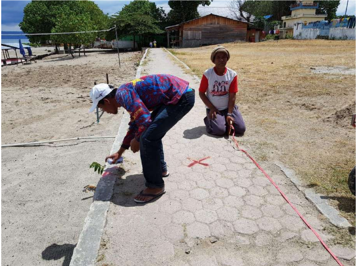
Gambar 5.11. Foto pelaksanaan kegiatan pemetaan kondisi eksisting wilayah Desa Situngkir
