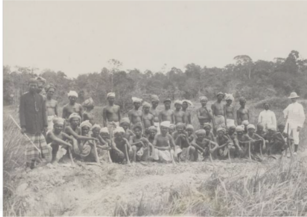
Gambar 2. Pekerja galian di sebuah perusahaan di sekitar Tebing Tinggi
