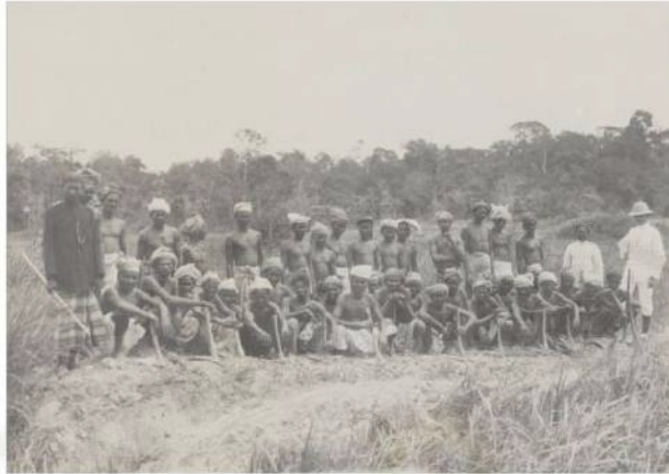
Gambar 2. Pekerja galian di sebuah perusahaan di sekitar Tebing Tinggi Sumber: kitlv.nl
