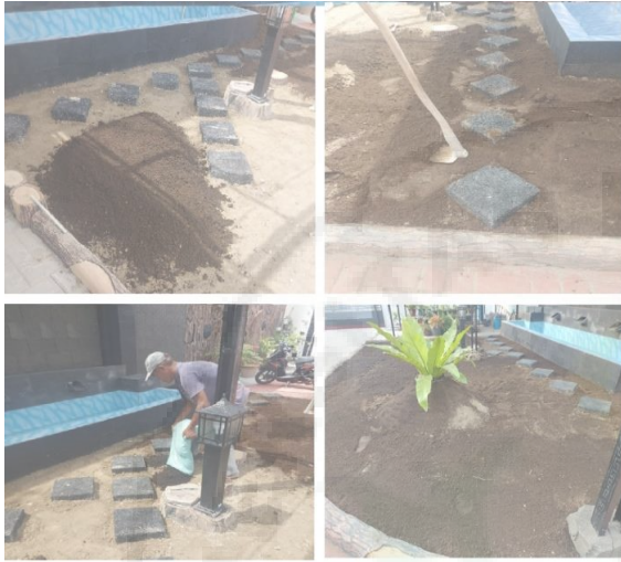
Gambar 7. Perletakan Material Pore Block Zeolit dan Pembentukan Taman Percontohan.
