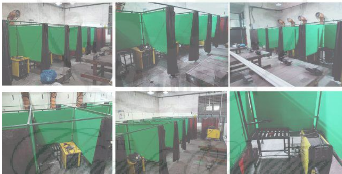
Gambar 5.2 Ruangan pengelasan sebanyak 16 unit yang sudah direnovasi secara total meliputi instalasi listrik, faktor keamanan, clemp, mesin las SMAW
