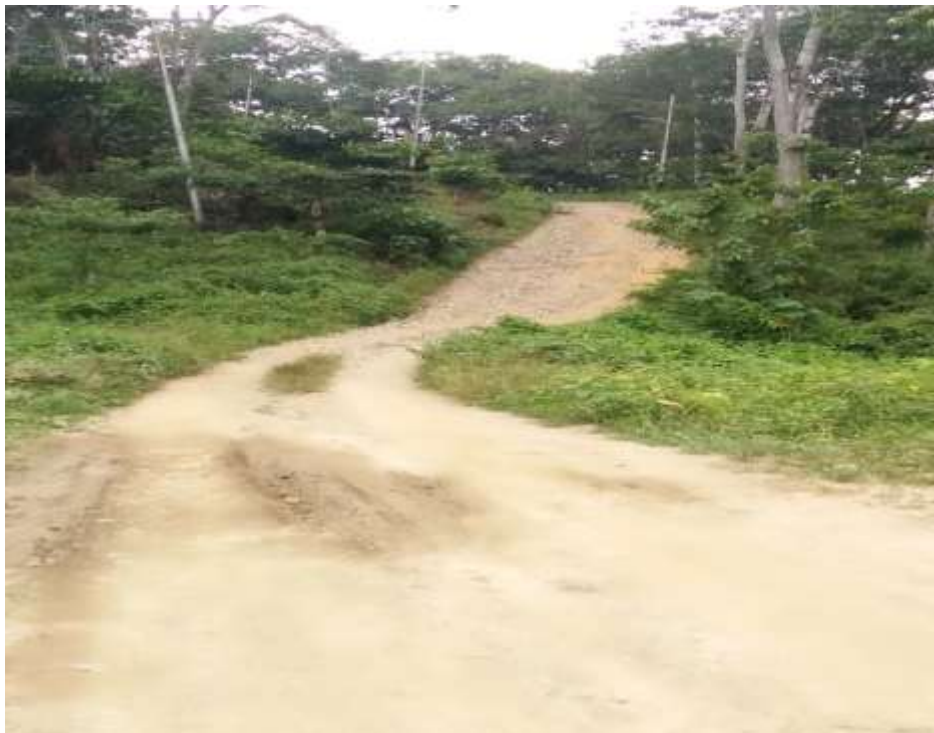
Gambar 4. Kondisi Jalan Menuju Desa Lau Lebah Kecamatan Gunung Sitember.
