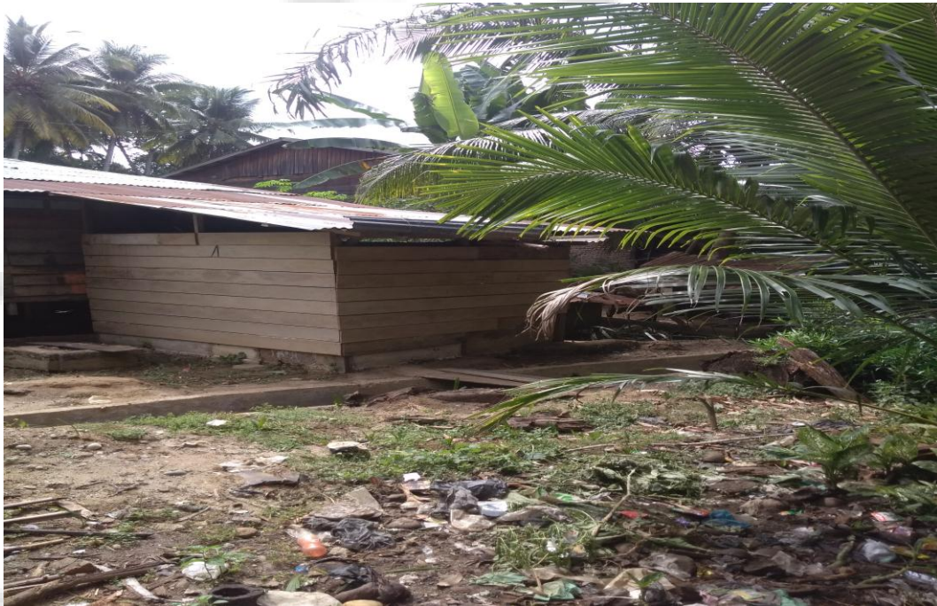
Gambar 11. Septick tank hanya berjarak 2 meteran saja dari sumur warga
