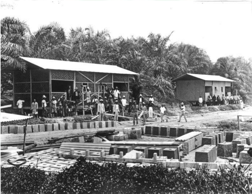
Pembangunan Barak Kuli milik Nijkerk, 1927
