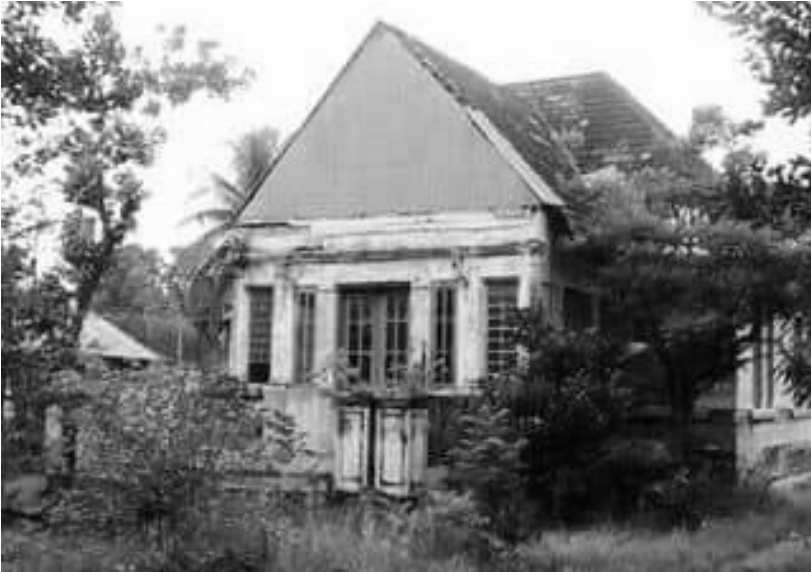
Kondisi terkini Rumah Raja Siantar di Pulau Holang Sumber: Dok. penulis
