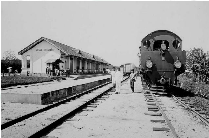
Stasiun Kereta Api DSM Dolog Malangir, Simalungun, 1925 Sumber: kitlv.nl
