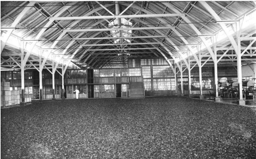
Pengeringan Teh di Kasindir, 1920 Sumber: kitlv.nl
