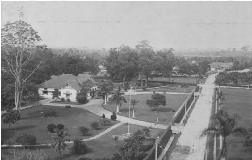
Huis van Controleur (Rumah Kontrolir) Siantar, 1930
