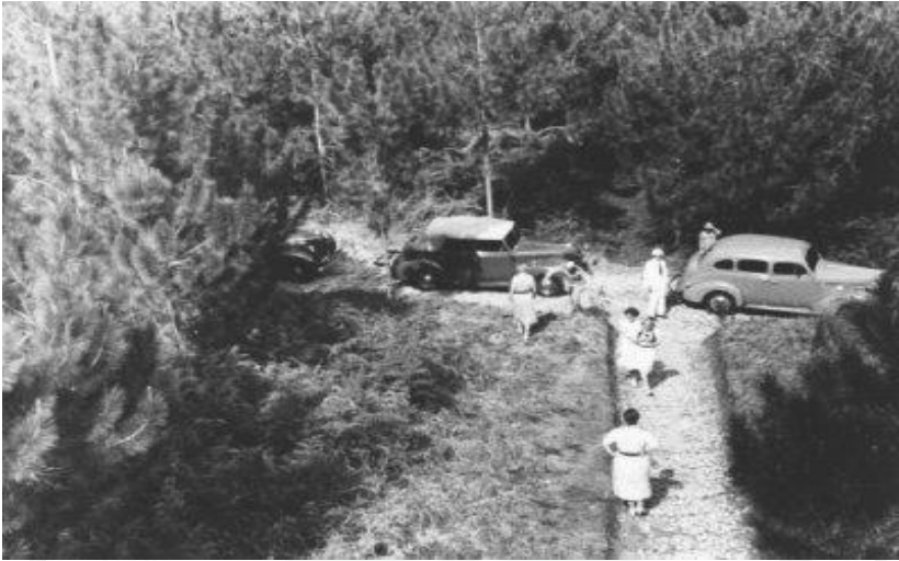
Pembangunan jalan di Bandar Dolog ke Parapat, 1937
