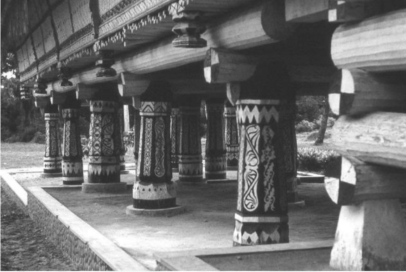
Konstruksi tiang rumah bolon Pematangpurba, 1971 Sumber: kitlv.nl
