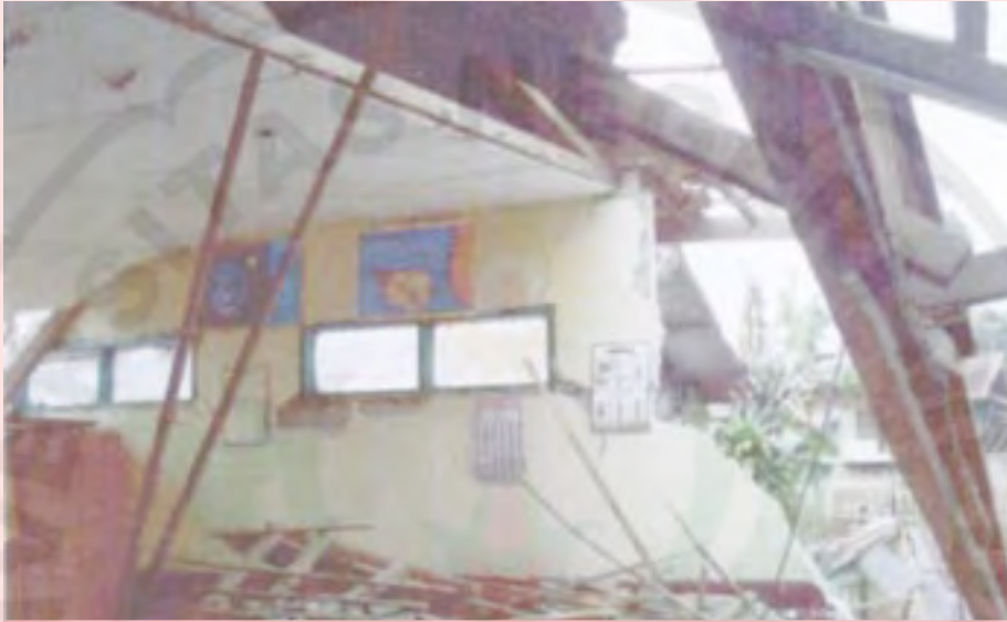
Salah satu SD dengan kondisi ruang kelas rusak akibat gempa di Jawa Barat.
