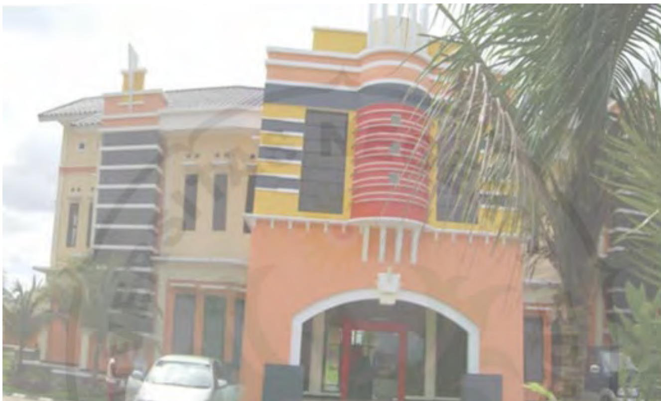
Gedung TK SD Bertaraf Internasional Kota Malang. Salah satu contoh hasil program pembangunan sarana dan prasarana TK SD.
