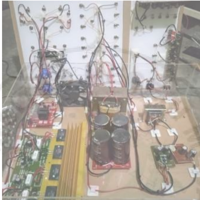
Gambar 4. 2 Pemasangan Komponen Sekaligus Penyambungan Kabel Pada Akrilik
