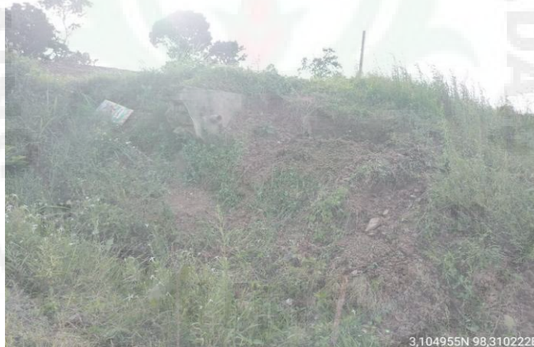
Gambar 1. 1 Bencana Tanah Longsor Desa Sari Nembah, Kabupaten Karo (Data Lapangan 2024)
