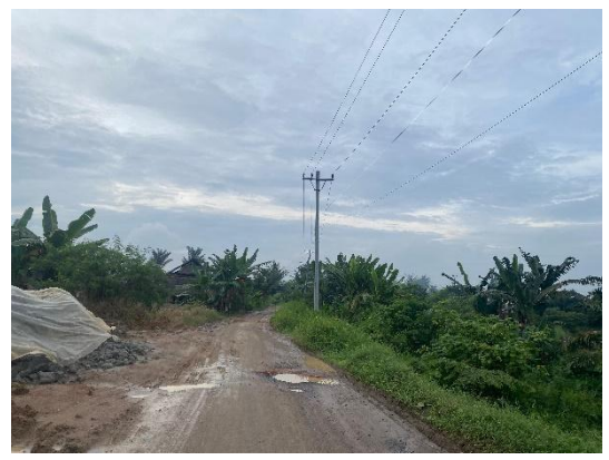
(Obv 6) Kondisi jalan lintas warga (Jumat, 7 Februari 2025)
