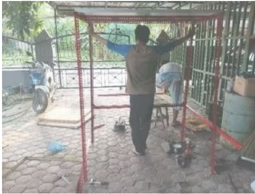
Gambar 5. Perakitan Rangka Panel Surya
