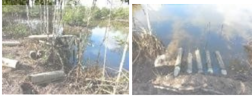
Gambar 5. Kondisi Pintu Air Tambak Sebelum dan Sesudah Diperbaiki
