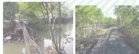
Gambar 4. Kondisi Benteng (Dinding Tambak) Sebelum dan Sesudah Diperbaiki
