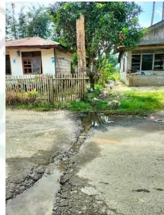
**Gambar 1. 4 Kebocoran saluran**
