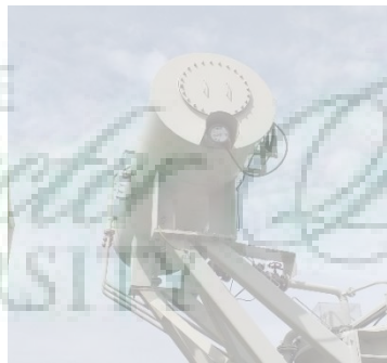
Gambar 2.8 Tangki Konservator Transformator Daya
