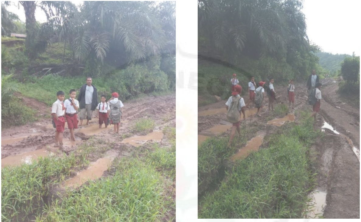
Gambar 5. Kondisi jalan Dusun Binasari pada musim hujan
