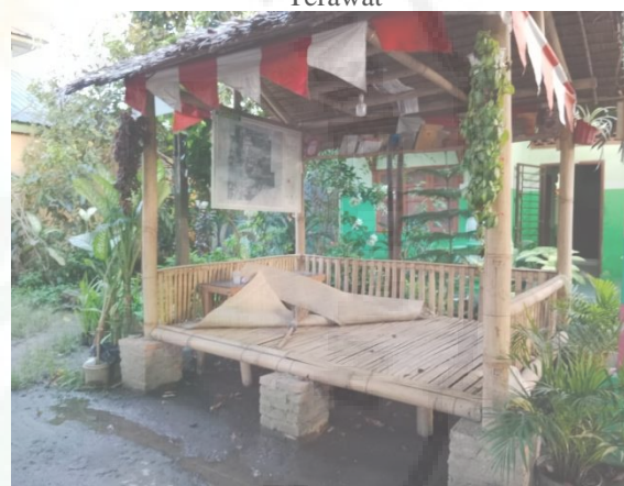
Gambar 3. Pendopo Baca yang Sudah Tidak Layak
