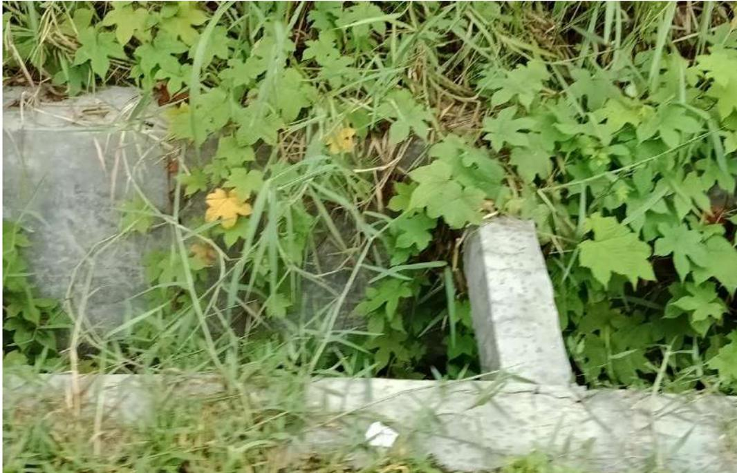
Gambar 1.3. Kondisi saluran drainase permanen yang tidak terawat dan banyak rerumputannya
