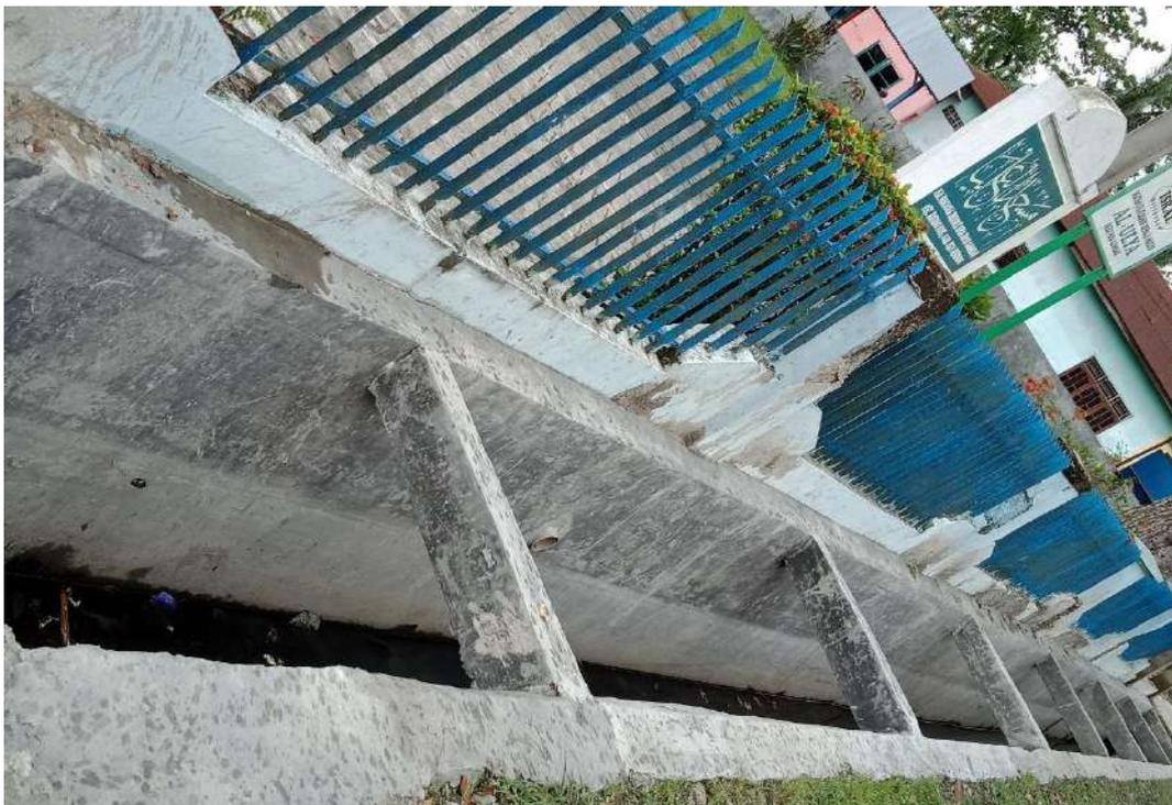
Gambar 1.4. Kondisi saluran drainase permanen yang tidak terawat dan di dasarnya banyak sampah dan sedimen tanah sehingga airnya hanya menggenang
