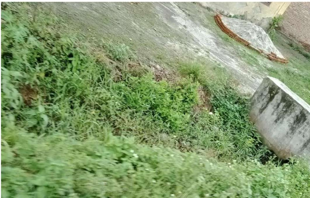
Gambar 1.2. Kondisi saluran drainase non permanen yang masih terbuat dari hasil penggalian tanah, yang tidak terawat dan banyak rerumputannya
