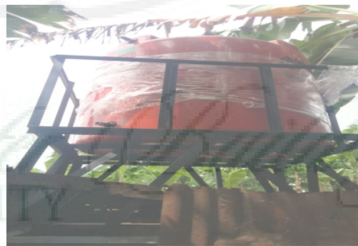
Gambar 10 Tower dan Tangki Air 1000L
