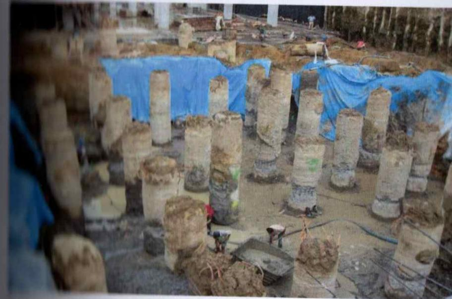
Gambar 3.1. Pekerjaan Bor Pile sebagai Pondasi Pancang
