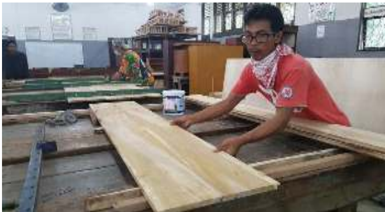
Gambar 5.13. Proses Penyambungan Papan
