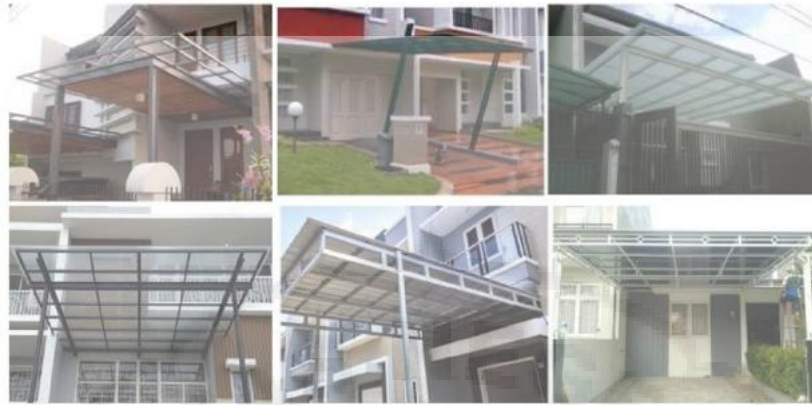
Gambar 6. Produk las fabrikasi logam jenis Kanopi dari bahan baja lunak, steinless steels, maupun baja ringan dengan berbagai motif dan ornamen
