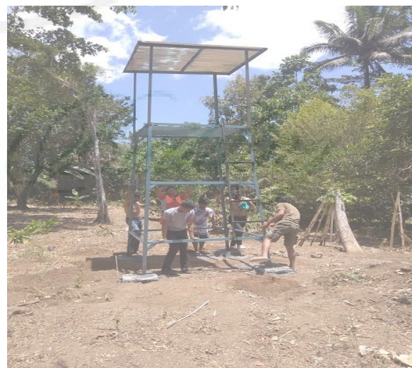
Gambar 7. (atas) Mahasiswa KKN sedang mengerjakan pembuatan rangka menara tangki air; (bawah) Rangka menara tangki air yang sudah selesai dikerjakan, dipindahkan ke lokasi penanaman pepaya.
