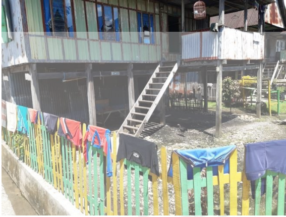
Gambar 2. Rumah tidak memiliki jamban, drainase, bak penampungan air kotor
