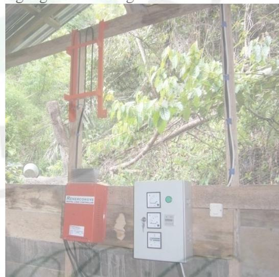
**Gambar 10.** perangkat pengatur tegangan generator dengan menggunakan ballast load
