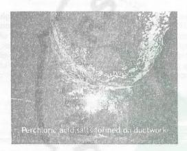
Gambar 1. Korosi yang terbentuk pada saluran pipa keluar (www.mkplastics.com 2006)
